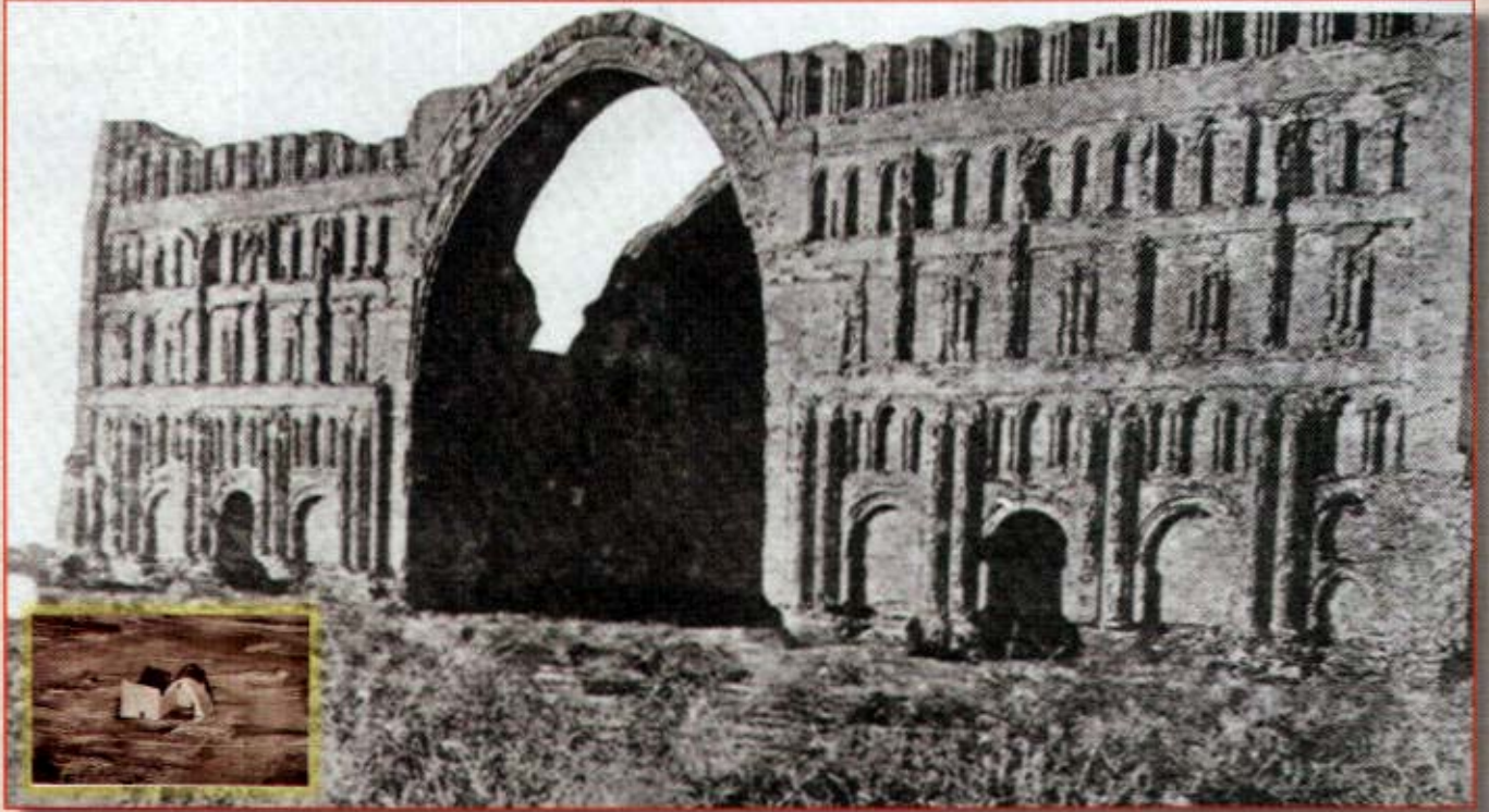
واجهة إيوان كسرى قبل سقوط الجناح الأيمن من واجهة القصر وكان انهيار هذا الجناح في ١٥ نيسان ١٨٨٨م عند فيضان نهر دجلة - م . الصورة، شريف منصور .
