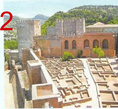
قلعہ القصبہ (مالگا)
